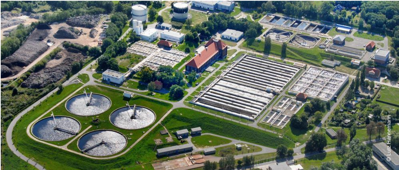
(Foto: Das aktuelle Klärwerk im Betrieb)
