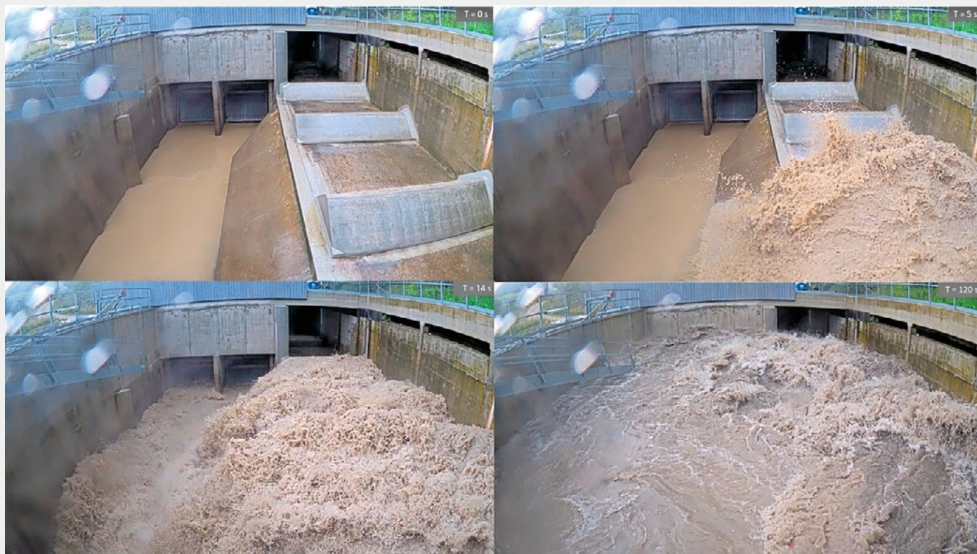
Fig. 6 Episode pluvieux du 8 juillet 2023. Le débit maximum enregistré dans le canal amont atteint 25,6 \text{ m}^3/\text{s} . Les images représentent la prise d'eau à 0 s, 4 s, 14 s et après 120 s.
