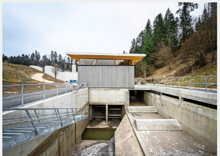
Fig. 3 Prise d'eau dans le canal d'évacuation des eaux de la ville. L'escalier amovible permet un accès facilité à la partie amont des dégrilleurs et le centre de la prise.
