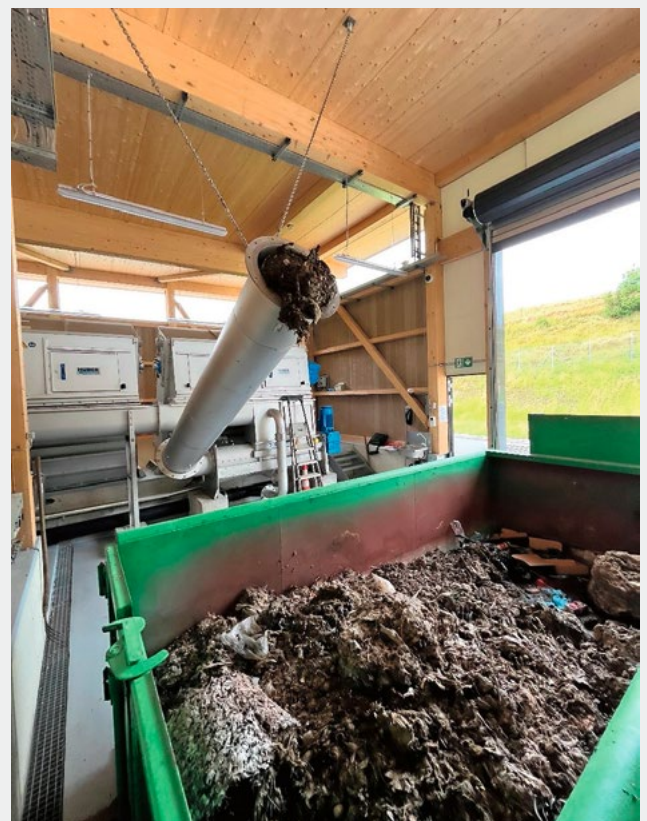
Fig. 5 Nouveau local des dégrilleurs avec structure en bois.
